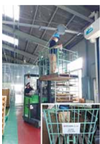
【安全衛生対策】高所作業の安全対策 (柵付き高所作業台の導入)
